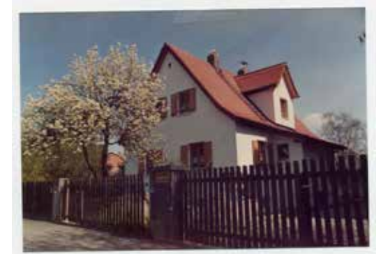
Wohnhaus Familie Gai, erbaut 1927, renoviert 1990
