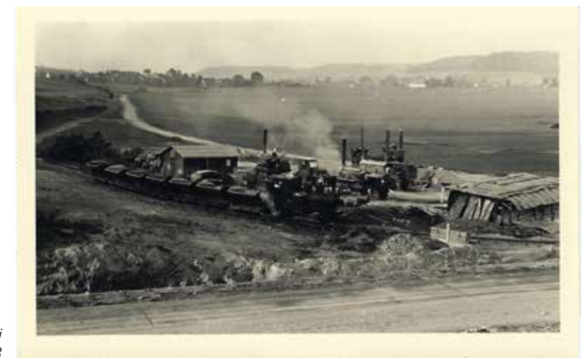
Autobahnbau bei Zusmarshausen, 1938
