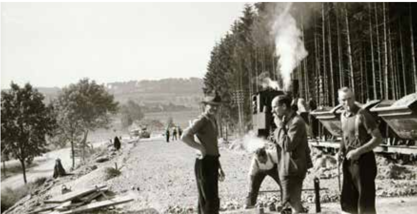
Autobahnbau bei Zusmarshausen, Datum unbekannt
