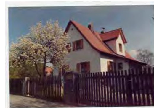
Wohnhaus Familie Gai, erbaut 1927, renoviert 1990
