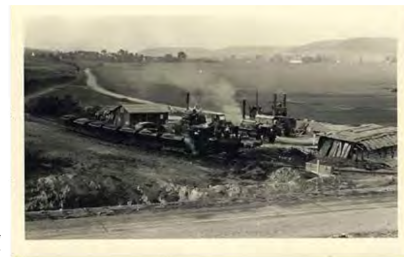
Autobahnbau bei Zusmarshausen, 1938
