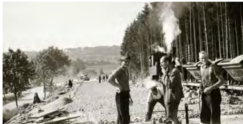
Autobahnbau bei Zusmarshausen, Datum unbekannt
